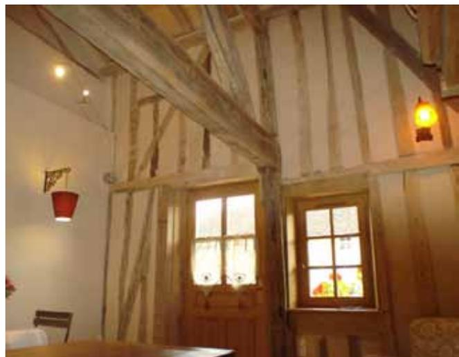
Les pans de bois sont en chêne ou peuplier, assemblés à tenons et mortaises, réalisés en fonction de leur orientation.
