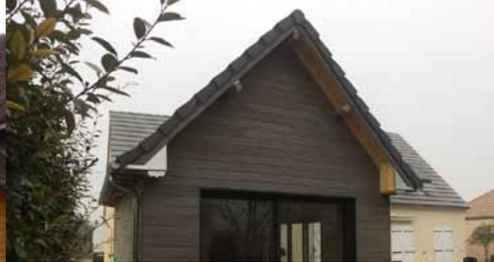
En création, c'est une double peau qui protège des intempéries et permet d'éviter les ponts thermiques.
